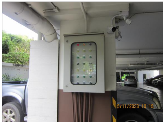
ภาพที่ 2.2-11 ตู้ควบคุมระบบบำบัดน้ำเสีย
