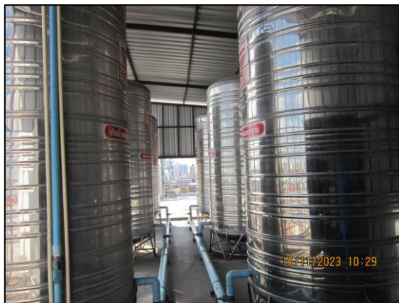
ภาพที่ 2.2-8 ถังสำรองน้ำใช้บนดาดฟ้าและใต้ดินภายในโครงการ
